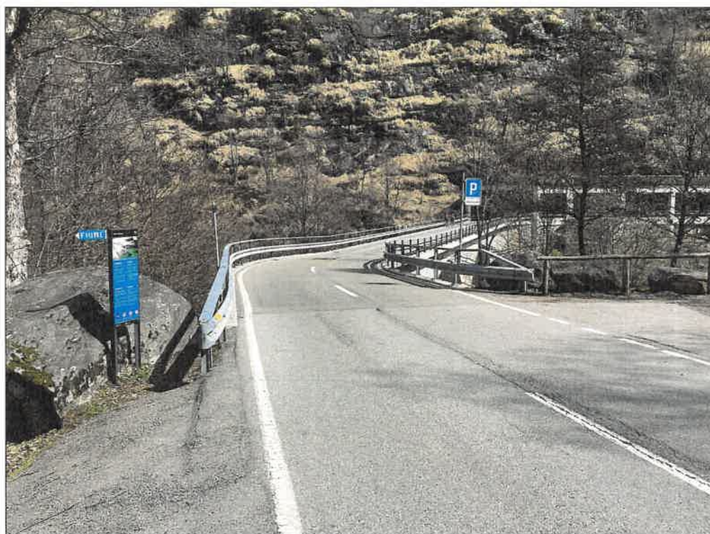
Foto località Ponte Gannone, Brione
