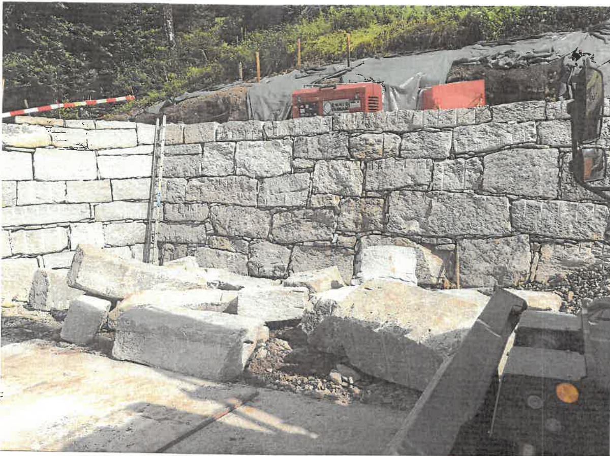
Figura 6: Esempio muro di contenimento in blocchi ciclopici
