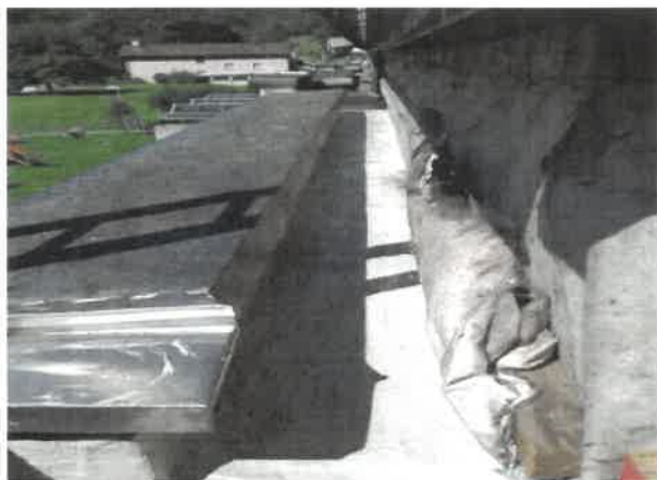
dettagli del tetto
