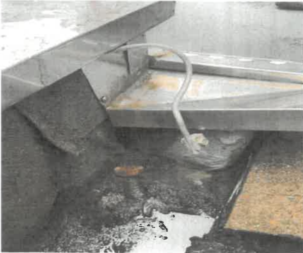
dettagli del tetto
